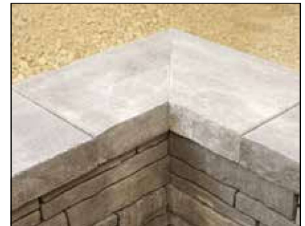
Diagram 11—45-degree miter
